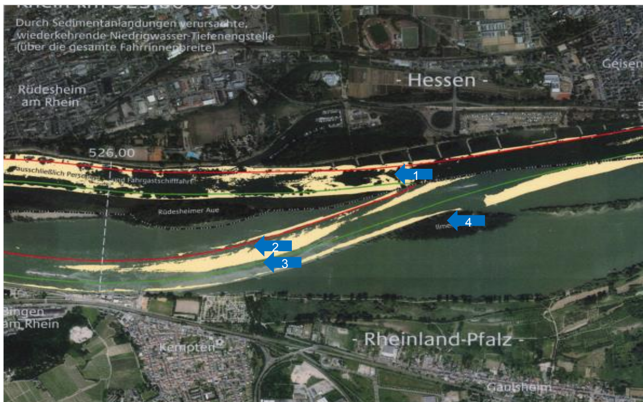
Abbildung 8: Tiefenengstelle Kemptener Fahrwasser – Workshop Schifffahrt
